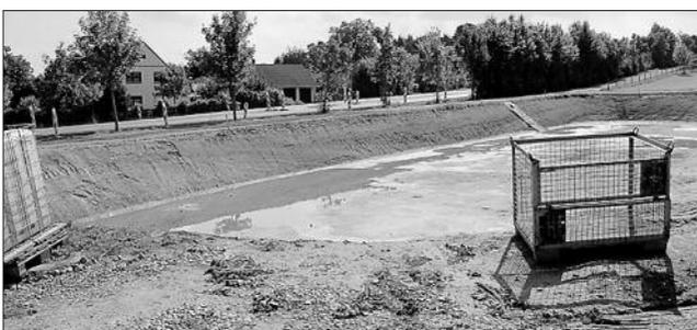
Regenrückhaltung und Querungshilfe sind weitgehend fertiggestellt, noch aufzustellen ist die Beleuchtung; in Kürze wird der Radweg asphaltiert.
