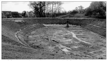
Nach knapp zweimonatiger Bauzeit sind die Bauarbeiten zur Erweiterung des Aurachweihers abgeschlossen. Mit der Vergrößerung des Rückhaltevolumens von ca. 2.300 m³ auf nunmehr 5.000 m³ wurde der Hochwasserschutz für Aurach deutlich verbessert.
