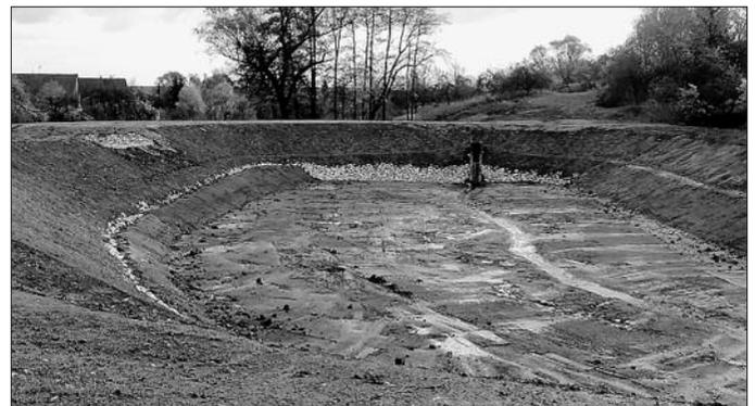
Nach knapp zweimonatiger Bauzeit sind die Bauarbeiten zur Erweiterung des Aurachweihers abgeschlossen. Mit der Vergrößerung des Rückhaltevolumens von ca. 2.300 m<sup>3</sup> auf nunmehr 5.000 m<sup>3</sup> wurde der Hochwasserschutz für Aurach deutlich verbessert.
